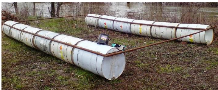
Slika 127. Burad, nosivi dio kaveza
